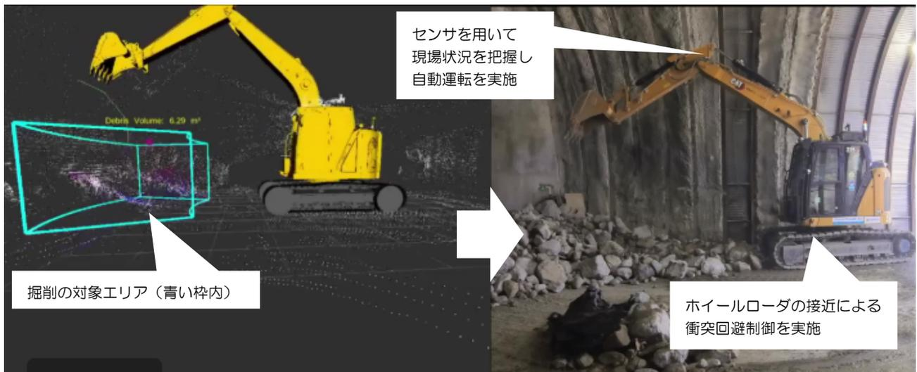
図3 自動化されたバックホウによるずり集積状況
